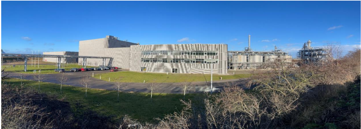
Figur 17: Meliora Bio's nuværende produktionsfacilitet for 2G Bioetanol der nu er integreret med Comets produktionsfacilitet for præbiotika (Kilde: Meliora Bio)
